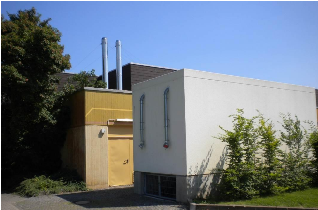
Pelletheizung der Hans-Pfeiffer-Halle in Lampertheim, © Stadt Lampertheim
