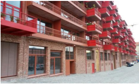
Modernes „Fabrikwohnen“ mit Pelletheizung
