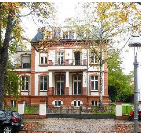
Gründerzeit-Villa heizt mit Erdwärme
