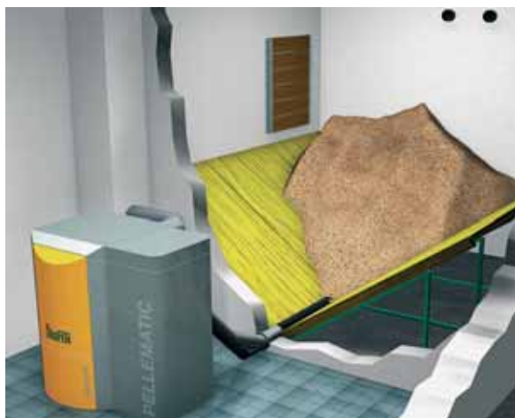
Beispiel für einen Pelletlagerraum Foto: ÖkoFEN Pelletsheizung, Mickhausen
